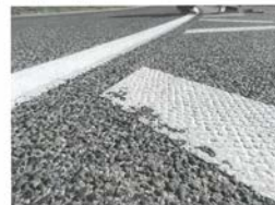
Slika 4: Obrabljen začetni rob tleh označbe v smeri poteka prometa
